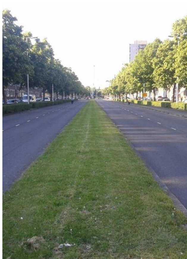
Figuur 4.2 Volledige afsluiting Dorpsweg Rotterdam
