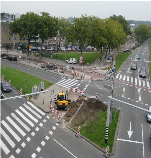
Figuur 2.1 Het kruispunt bij aanvang van de werkzaamheden.
