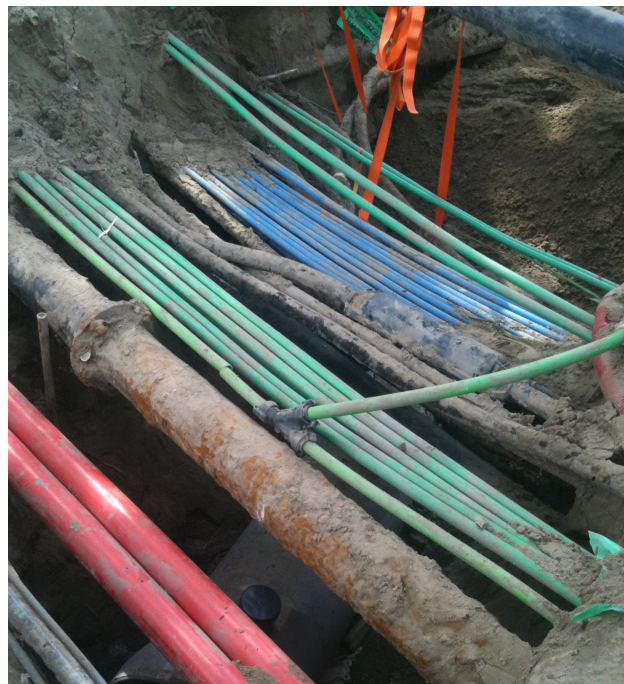
Figuur 3.4 Kabel en leidingen vragen aandacht I
