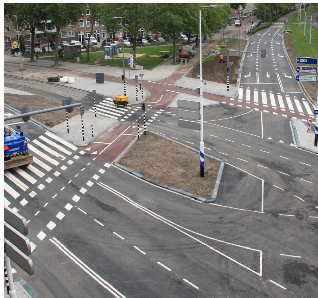
Figuur 2.3 Het kruispunt na de werkzaamheden.
