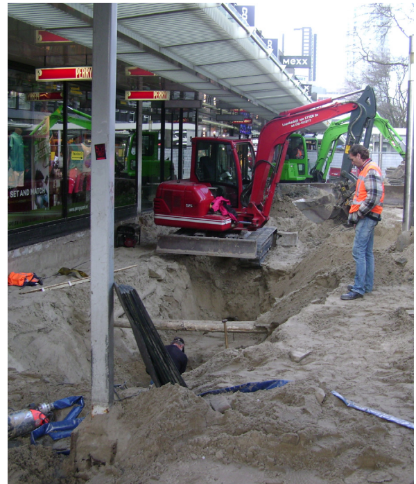
Figuur 3.1 Open tijdens de werkzaamheden
