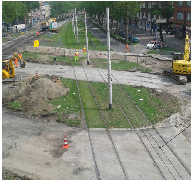
Figuur 2.2 Het kruispunt tijdens de werkzaamheden.
